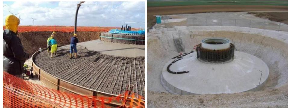
**Photographie 1: Fondations type avec le système de fixation du mât**
