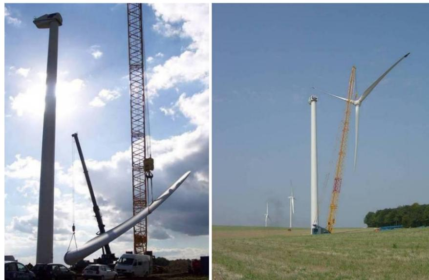
**Photographie 2: Grue de montage et élévation du rotor**
