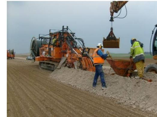
**Photographie 4: Tranchée pour l'enfouissement des câbles électriques**
